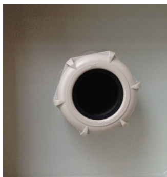
Figura 13 - Passaggio cavi DC
