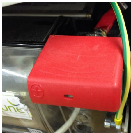
Figura 21 - Inserimento coperchi poli batteria
