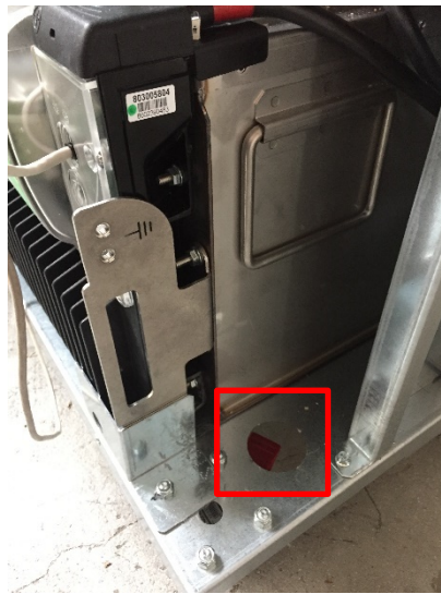
Figura 14 - Particolare del passaggio cavi
