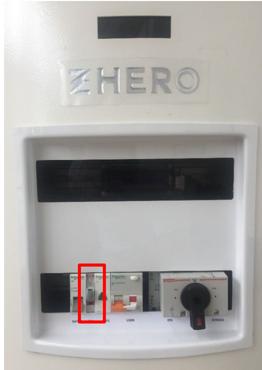
Figura 35 - Pulsante da premere per avviare la modalità test SPI
