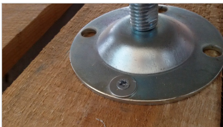
Figura 5 - particolare dei piedini con fori di fissaggio al pavimento
